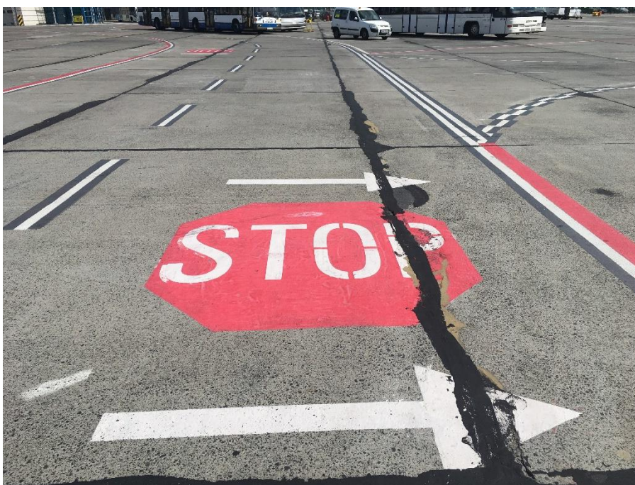
Oznakowanie STOP na drogach serwisowych.
