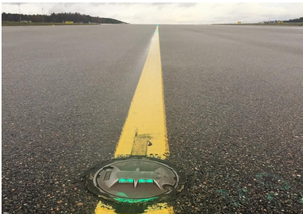
Oświetlenie osi dróg kołowania – zielone.
