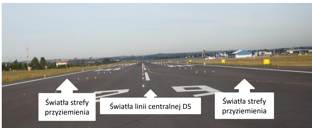
Oświetlenie krawędziowe, osi oraz strefy przyziemienia drogi startowej.
