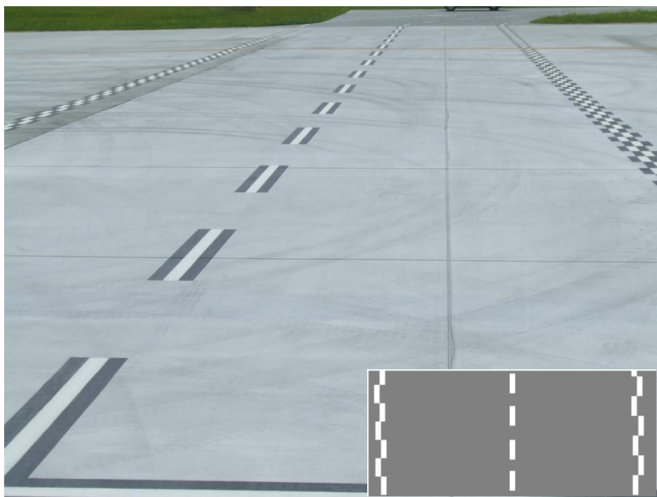
Droga serwisowa przecinająca drogę kołowania.
