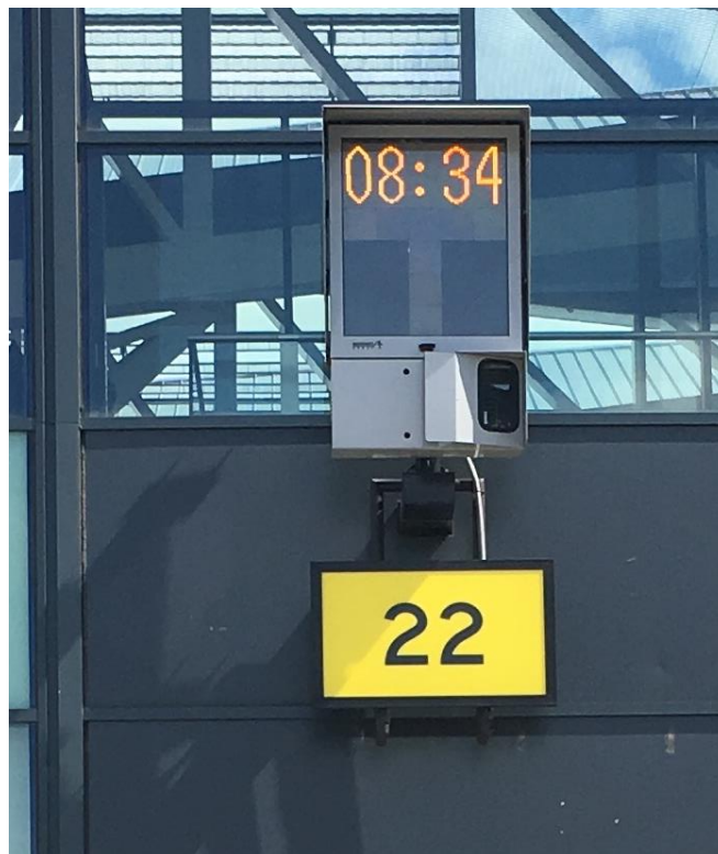
Znak pionowy wraz ze systemem dokowania – stanowisko nr 22.
