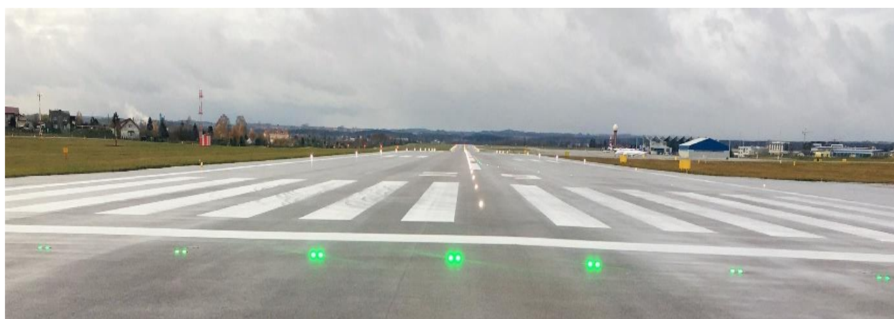
Zielone światła progu drogi startowej. W tle widoczne światła krawędziowe i osi drogi startowej.
