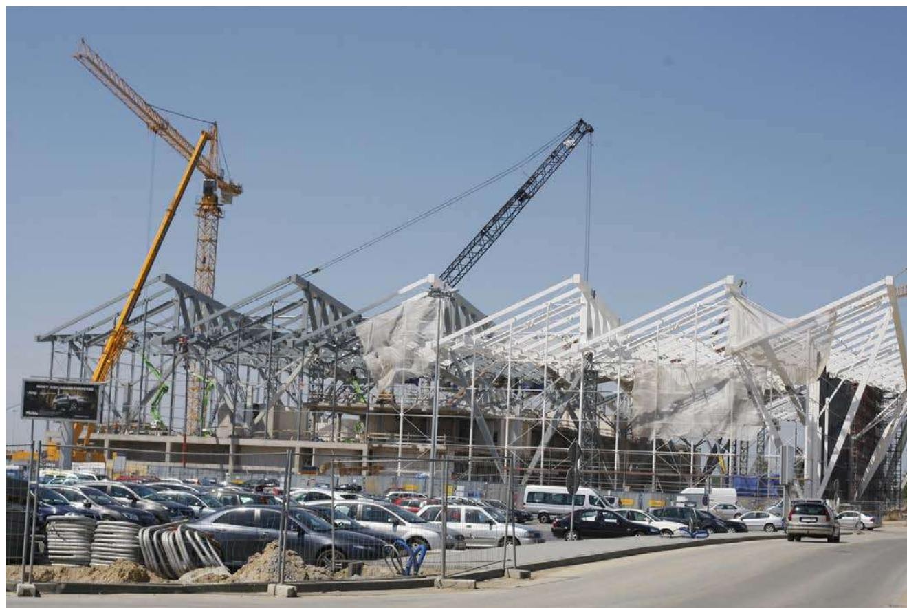
▲ Tak wyglądała budowa nowego Terminalu nr 2 w Porcie Lotniczym Gdańsk im. Lecha Wałęsy w 2011 roku
